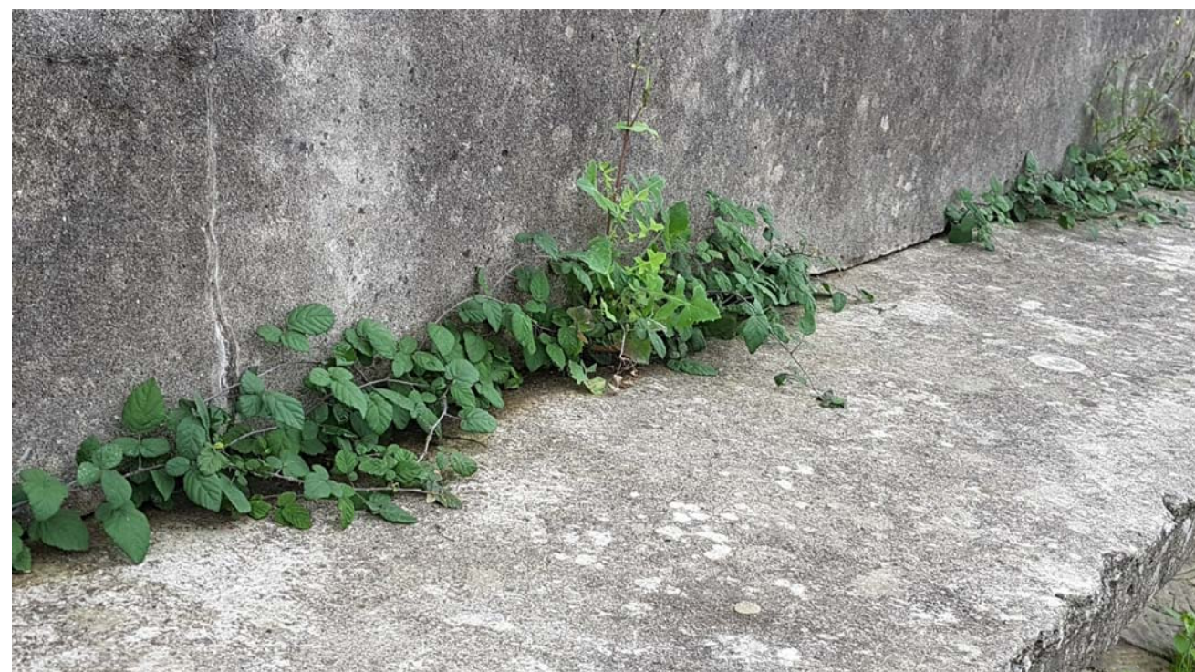
TIPICO ESEMPIO A CORRERE SU TUTTO IL TRATTO DI PRESENZA DI PIANTE INFESTANTI CRESCIUTE SULLA CONNESSIONE E DI MUSCHI E LICHENI PRESENTI SULLA SUPERFICIE ESTRADOSSALE
