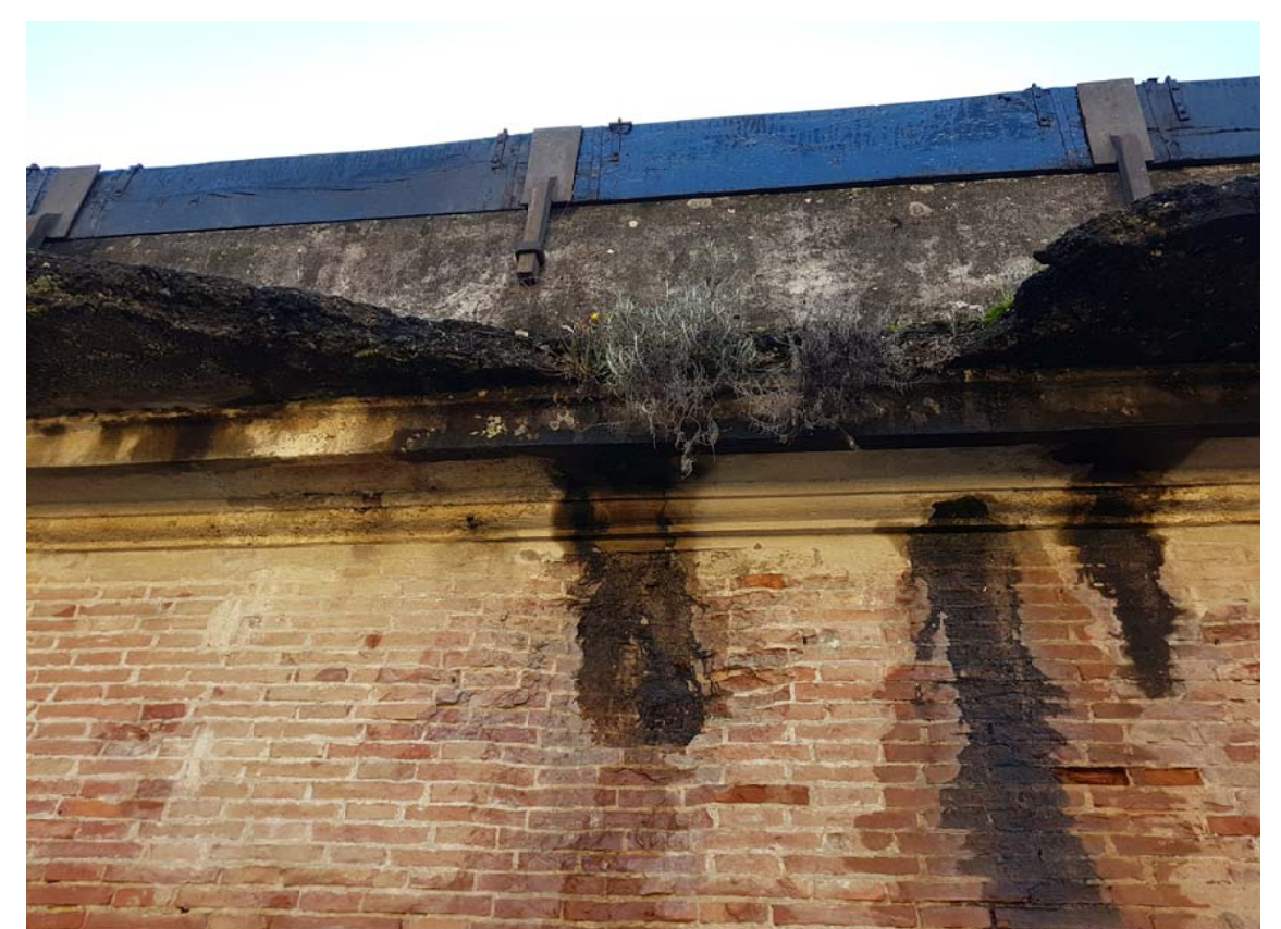
ALTRO ESEMPIO DI DETERIORAMENTO DELLA SOLETTA. PER QUESTE PORZIONI SI E' PREVISTA LA DEMOLIZIONE E RICOSTRUZIONE IN PROFILI DI ACCIAIO A SBALZO, RIVESTITI CON CEMENTO POZZOLANICO E RIFINITURA DEL TUTTO SIMILE ALL'ESISTENTE.
