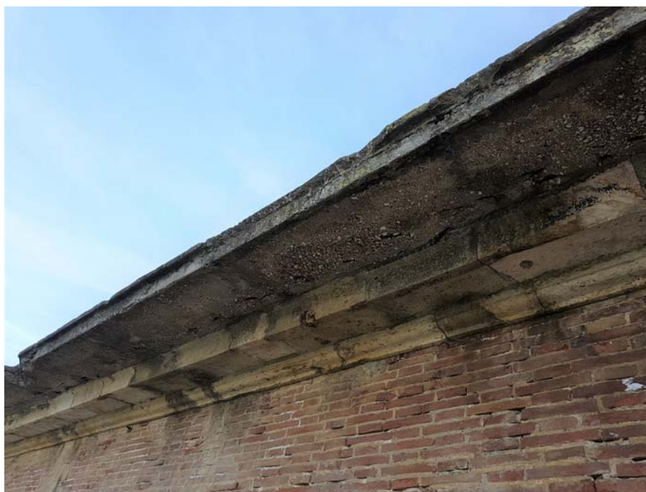
ALTRO ESEMPIO DI DETERIORAMENTO DELLA SOLETTA. PARTICOLARE DELL'INFRADOSSO DA CONSOLIDARE. SI NOTANO ANCHE LE "OMBRATURE" DEI PROFILI IN ACCIAIO A SBALZO. ANCHE SE CON DIFFICOLTÀ NELL'INDIVIDUARLI ALCUNI TRATTI SONO STATI REALIZZATI CON I PROFILI TIPO NP CHE CON LA SOLA ARMATURA A SBALZO TIPO "MOLLE" O MISTI
