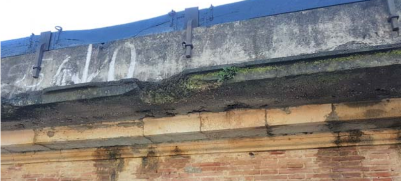
ALTRO ESEMPIO DI "INCISIONE" TIPICO DI TUTTI I TRATTI IL PROGETTO PREVEDE LA RICOSTRUZIONE DELLE PORZIONI MANCANTI CON STESSA TIPOLOGIA COSTRUTTIVA
