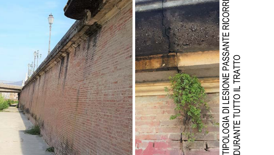
TIPOLOGIA DI LESIONE PASSANTE RICORRENTE DURANTE TUTTO IL TRATTO
