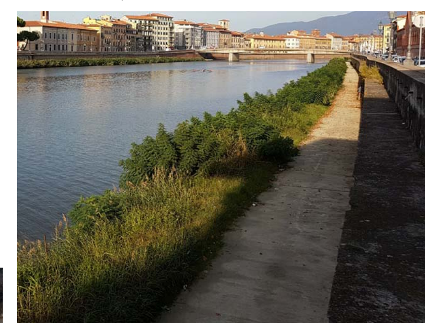
VISTA DI INSIEME ESTRADOSSO PENSILINA IN C.A. TRATTO 1 NOTASI LA FORMAZIONE DI LICHENI MUSCHI E PIANTE INFESTANTI
