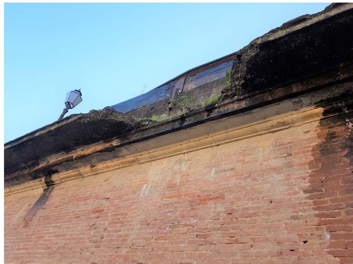
ALTRO ESEMPIO DI DETERIORAMENTO DELLA SOLETTA PER QUESTE PORZIONI SI E' PREVISTA LA DEMOLIZIONE E IL RIFACIMENTO CON TECNICHE DI RESTAURO INDICATE
