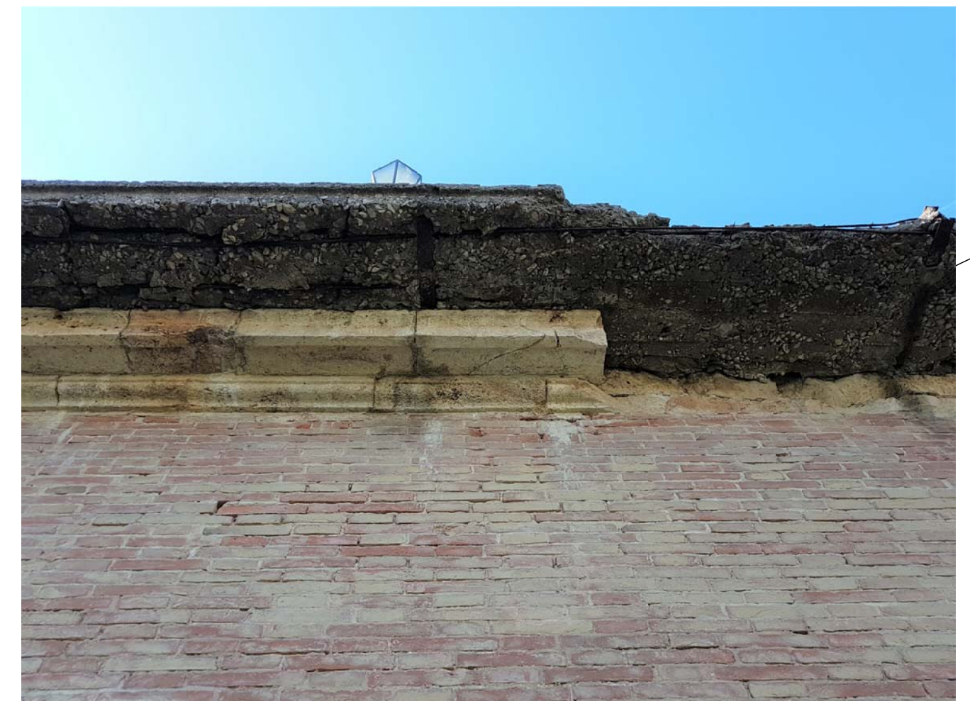
ALTRO ESEMPIO DI DETERIORAMENTO DELLA SOLETTA. PER QUESTE PORZIONI SI E' PREVISTA LA DEMOLIZIONE E RICOSTRUZIONE IN PROFILI DI ACCIAIO A SBALZO, RIVESTITI CON CEMENTO POZZOLANICO E RIFINITURA DEL TUTTO SIMILE ALL'ESISTENTE.
