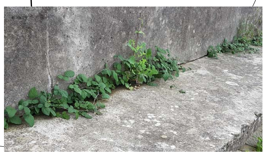
TIPICO ESEMPIO A CORRERE SU TUTTO IL TRATTO DI PRESENZA DI PIANTE INFESTANTI CRESCIUTE SULLA CONNESSIONE E DI MUSCHI E LICHENI PRESENTI SULLA SUPERFICIE ESTRADOSSALE
