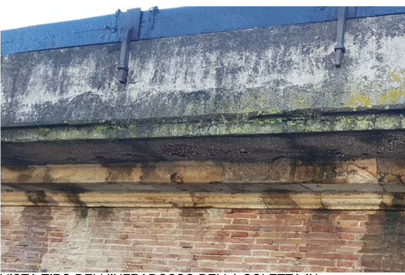
VISTA TIPO DELL'INFRADOSSO DELLA SOLETTA IN C.A. E DEL FRONTE DELLA SOTTOSTANTE MENSOLA IN PIETRA
