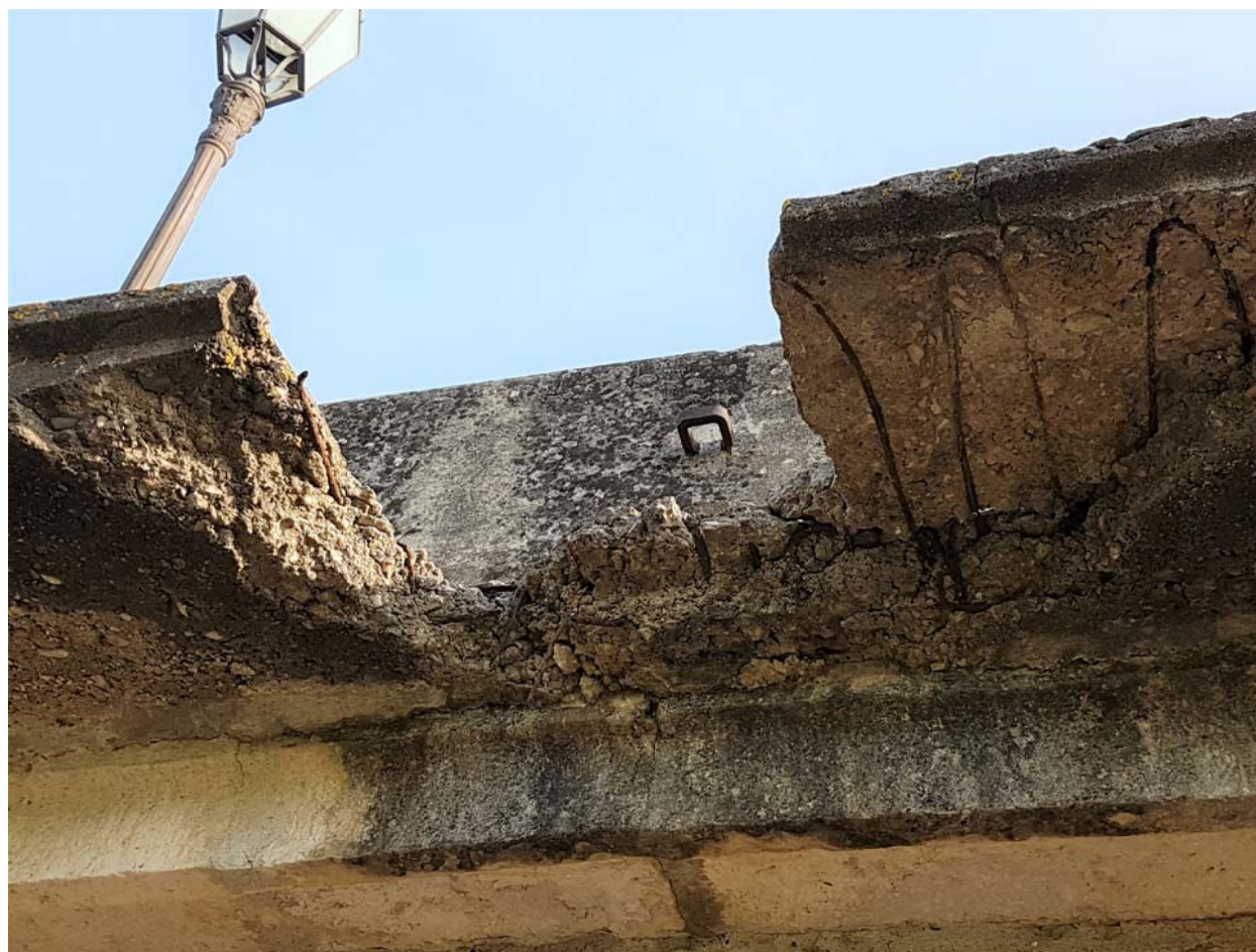
ALTRO ESEMPIO DI DETERIORAMENTO DELLA SOLETTA PER QUESTE PORZIONI SI E' PREVISTA LA DEMOLIZIONE E RICOSTRUZIONE CON MALTE POZZOLANICHE E FINITURE SIMILI NOTASI L'ARMATURA
