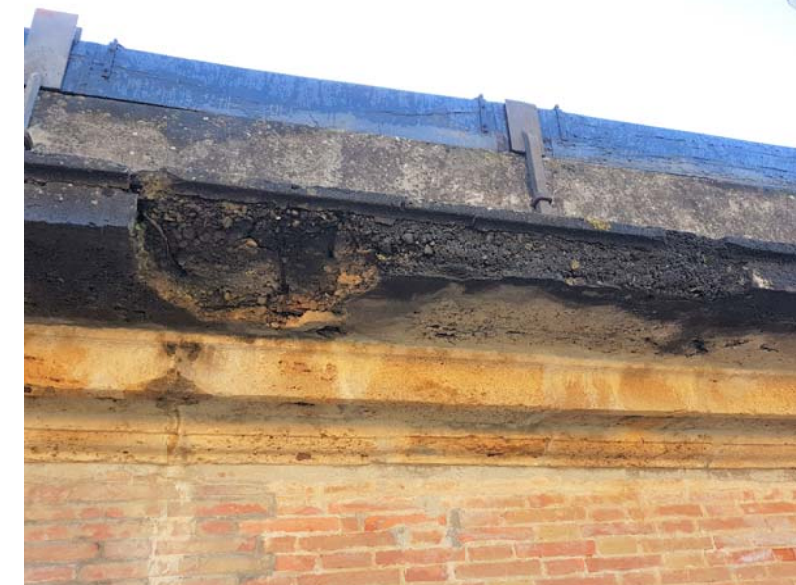
ALTRO ESEMPIO DI DETERIORAMENTO DELLA SOLETTA PER QUESTE PORZIONI SI E' PREVISTA LA DEMOLIZIONE E IL RIFACIMENTO VEDI TRATTI INDICATI IN ROSSO
